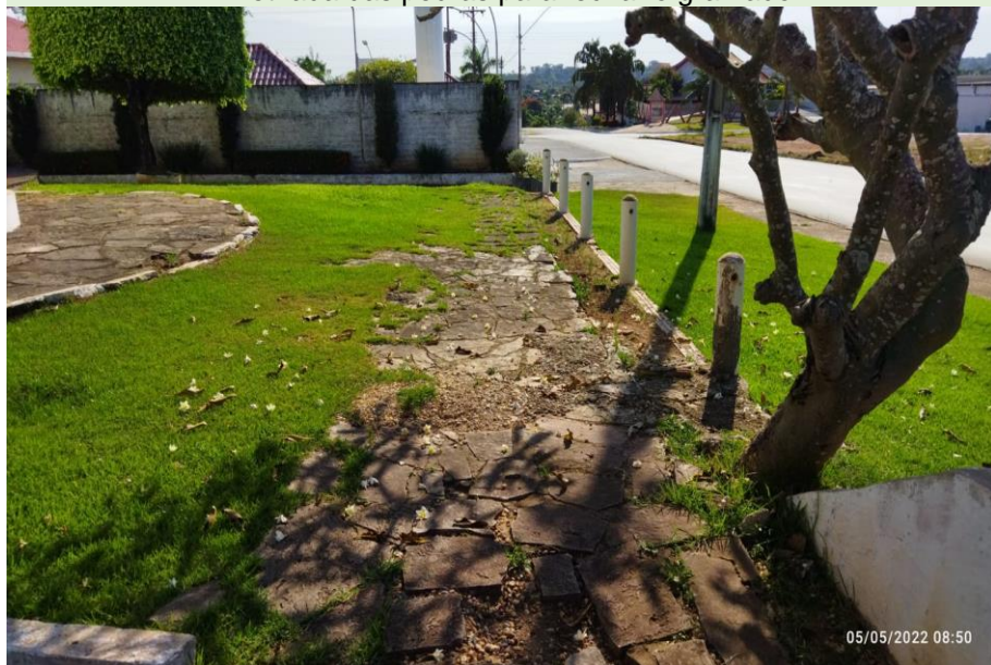
Pedras soltas e meio fio deteriorado
