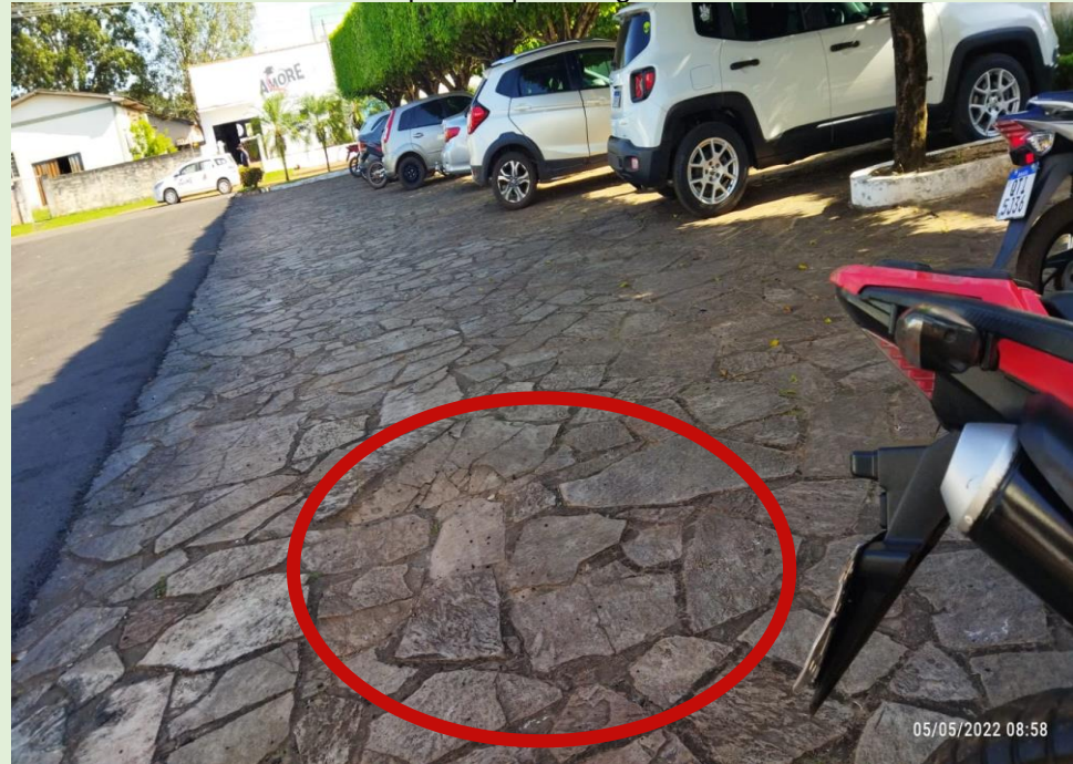
Pátio construído em pedras com várias locais que precisam de reconstrução pois empossa água
