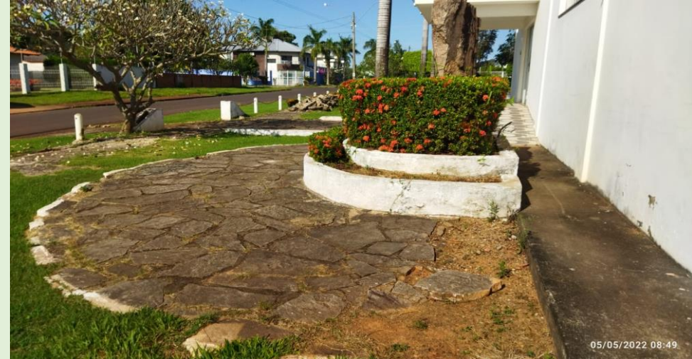
Calçada em pedra e meio fio - lado direito da porta do fundo do Plenarinho
