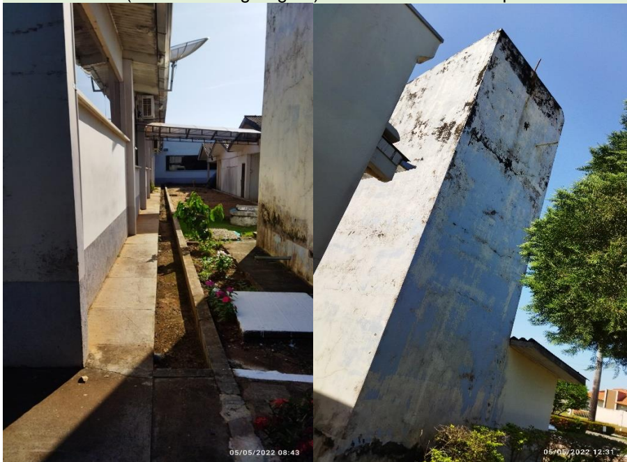
Pintura de toda parede externa e Caixa d'água – calçada – mureta e a vala entre ambas (Foto lado da garagem) – Verificar se a caixa precisa de rufos
