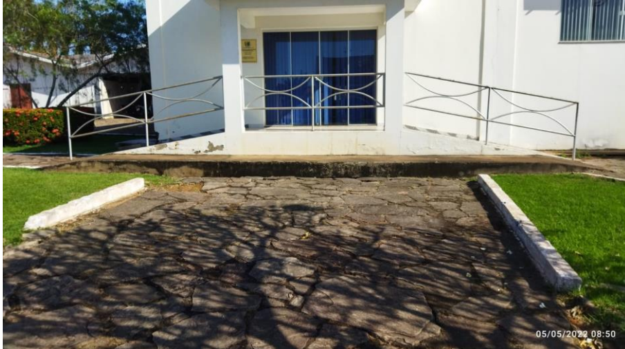
Calçada em pedra e meio fio - acesso ao Plenarinho pela porta do fundo
