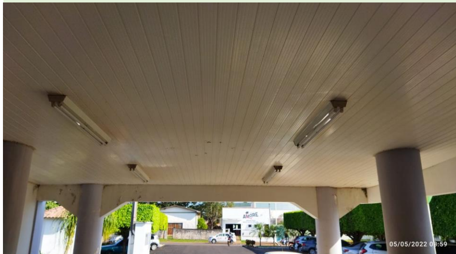
Troca de todo forro da fachada
