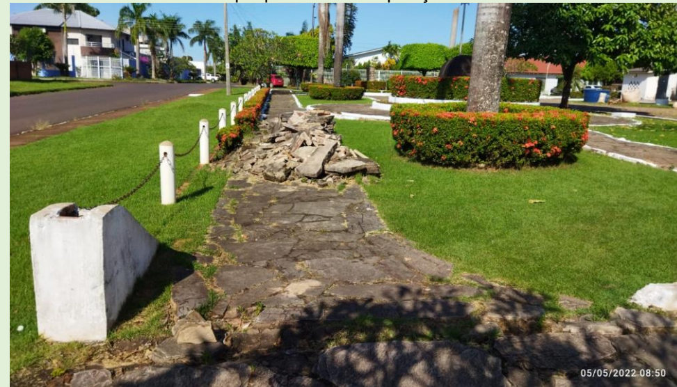
Pedras soltas no acesso pelo fundo e pedras para serem utilizadas nos locais que precisam de reposição
