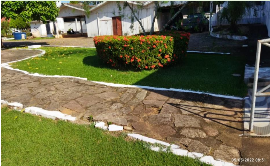
Calçada em pedra e meio fio - lado esquerdo da porta do fundo do Plenarinho
