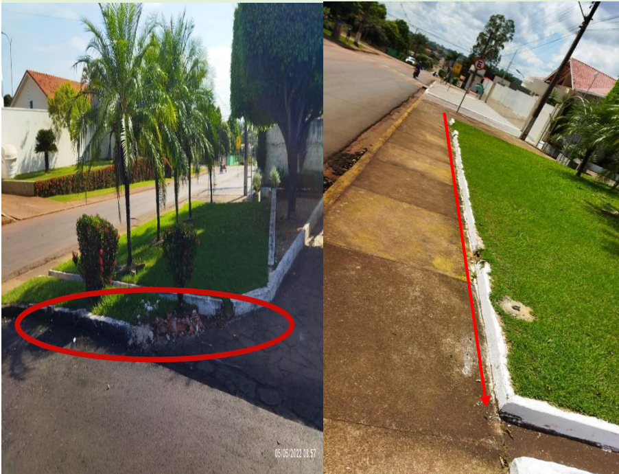
Meio fio da entrada e beira da rua da frente da Câmara deteriorado - reconstruir
